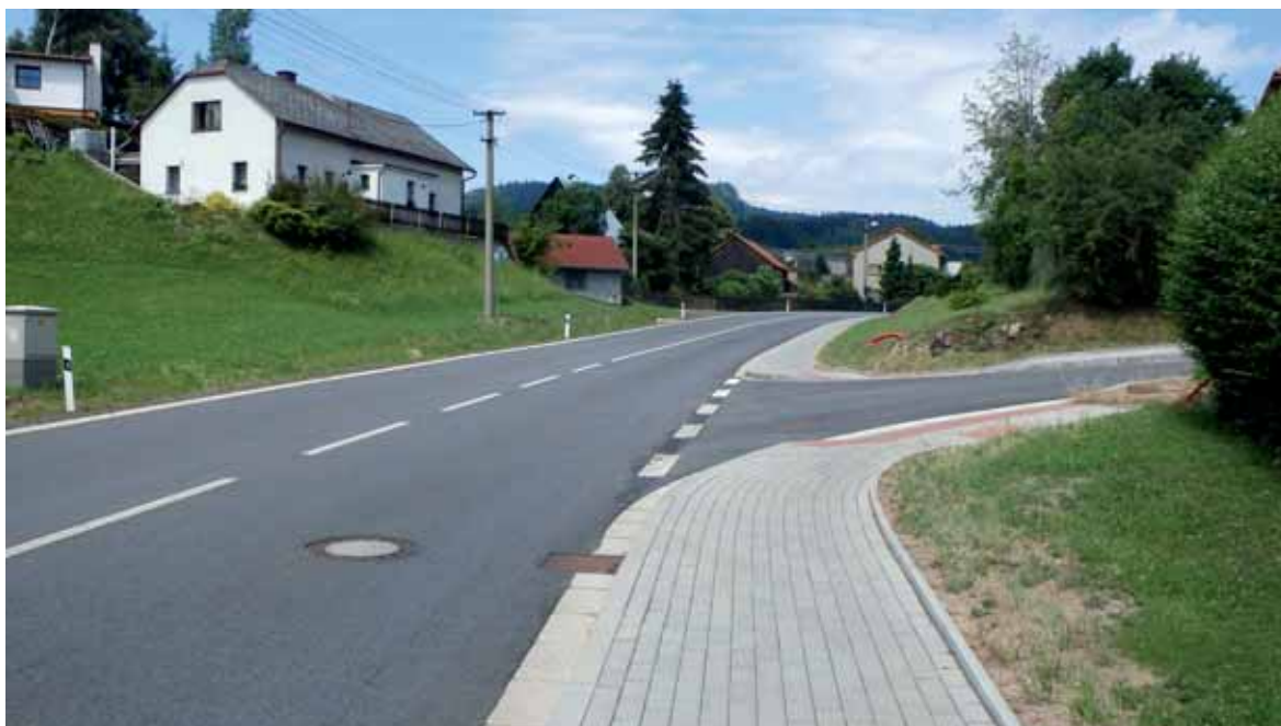
Rekonstrukce komunikace Police – Bukovice
