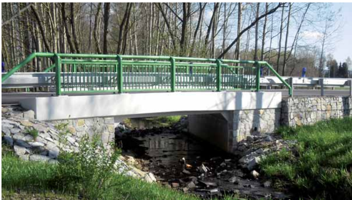
Rekonstrukce mostu u obce Trpnouze
