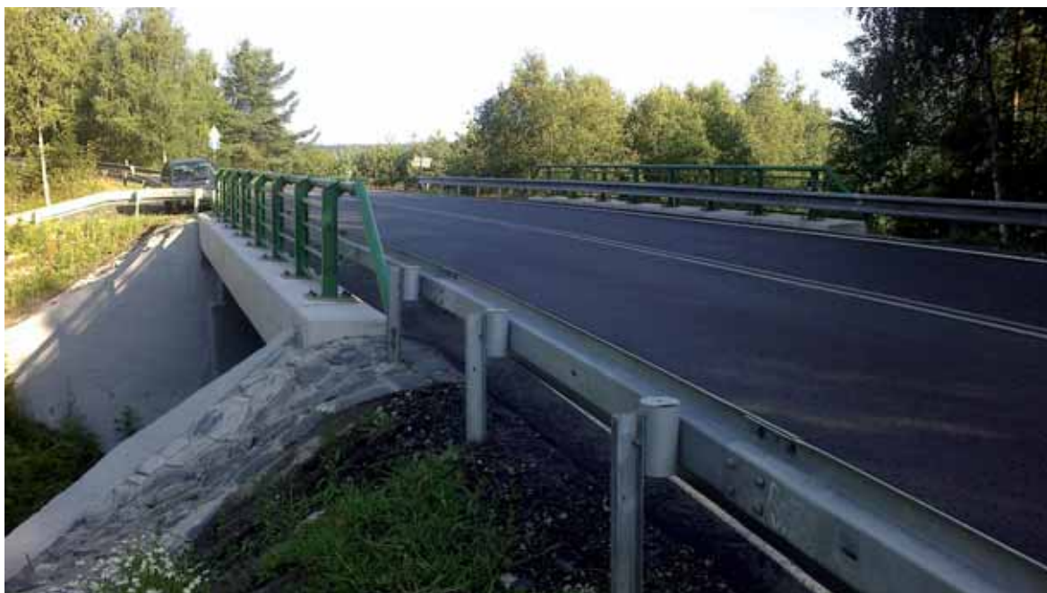
Rekonstrukce mostu ve Svoru
