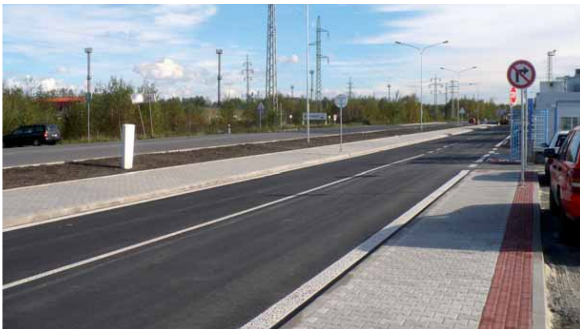
Přeložka I/9 MÚK Sosnová – úsek ulice U Obecního lesa
