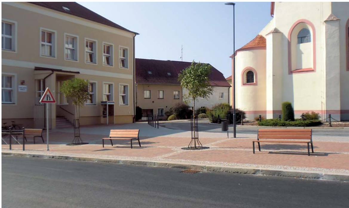
Rekonstrukce chodníků Rudolfov
