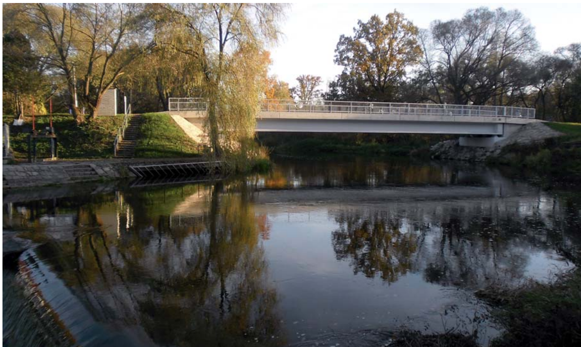
Rekonstrukce mostu v obci Hamr
